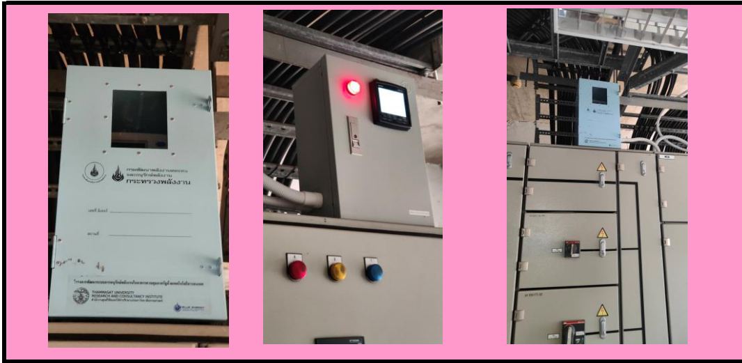
รูปที่ 5-2 ภาพก่อนดำเนินการปรับปรุง
